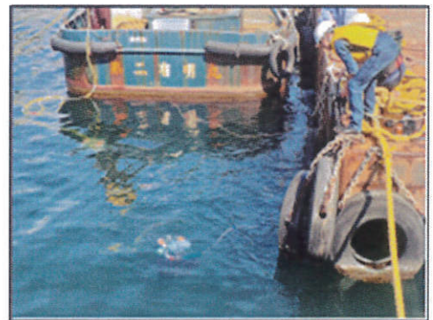
【③ROVへ搬送用具を設置し潜行】
